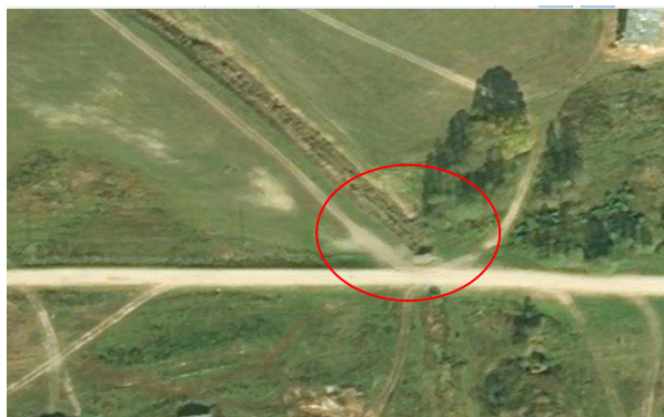
Рис. 2. Пример зарастания трубы-переезда кустарником
